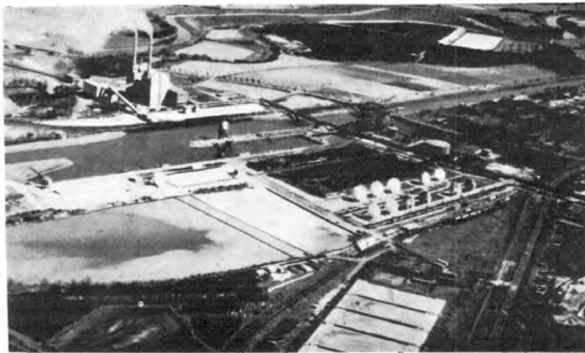
Fig. 5 Plant of Chemische Werke Huelst
