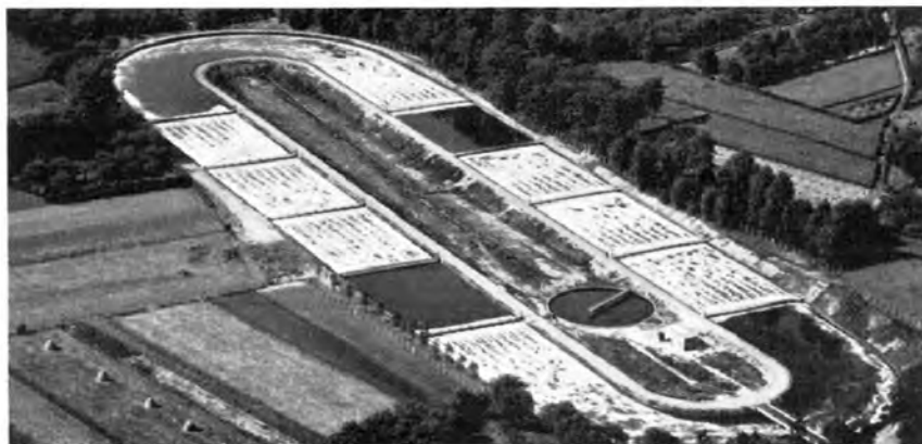
Fig. 2 Oxidation ponds
